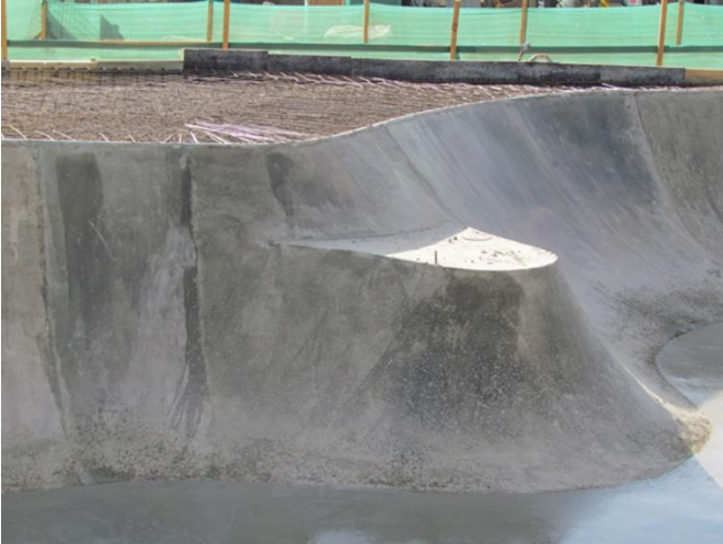
6) Bowl: Transición no tiene las curvaturas necesarias, no se podrá utilizar.
